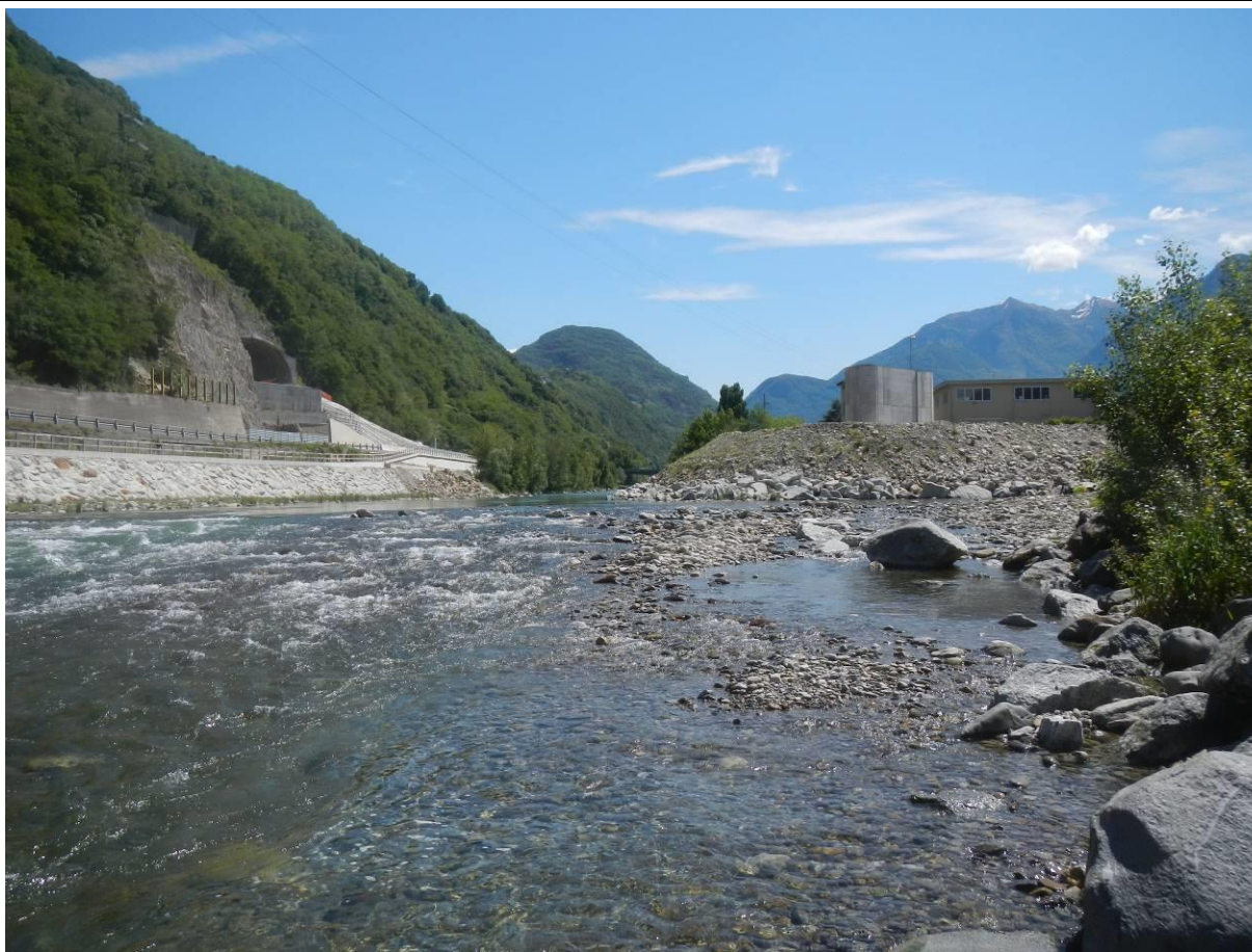
Foto n. 2 Sponda sinistra con deposito fine, sponda destra con difesa in calcestruzzo
