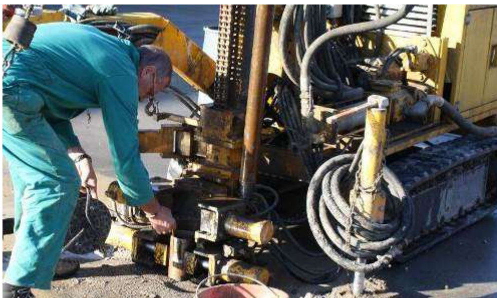
Fig. 4.24 Prova di permeabilità in foro
