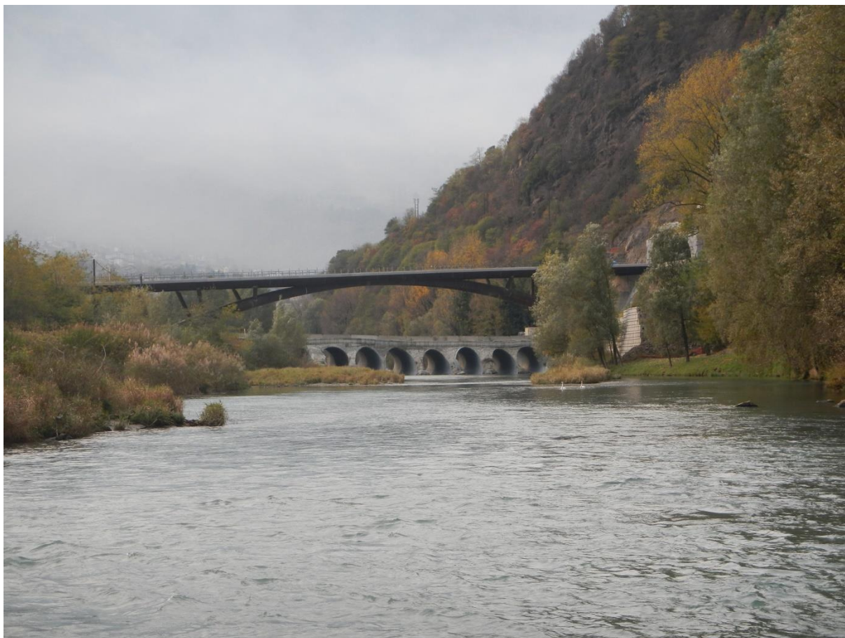
Figura 2.9 Tratto oggetto di monitoraggio; a valle è osservabile il ponte in costruzione.
