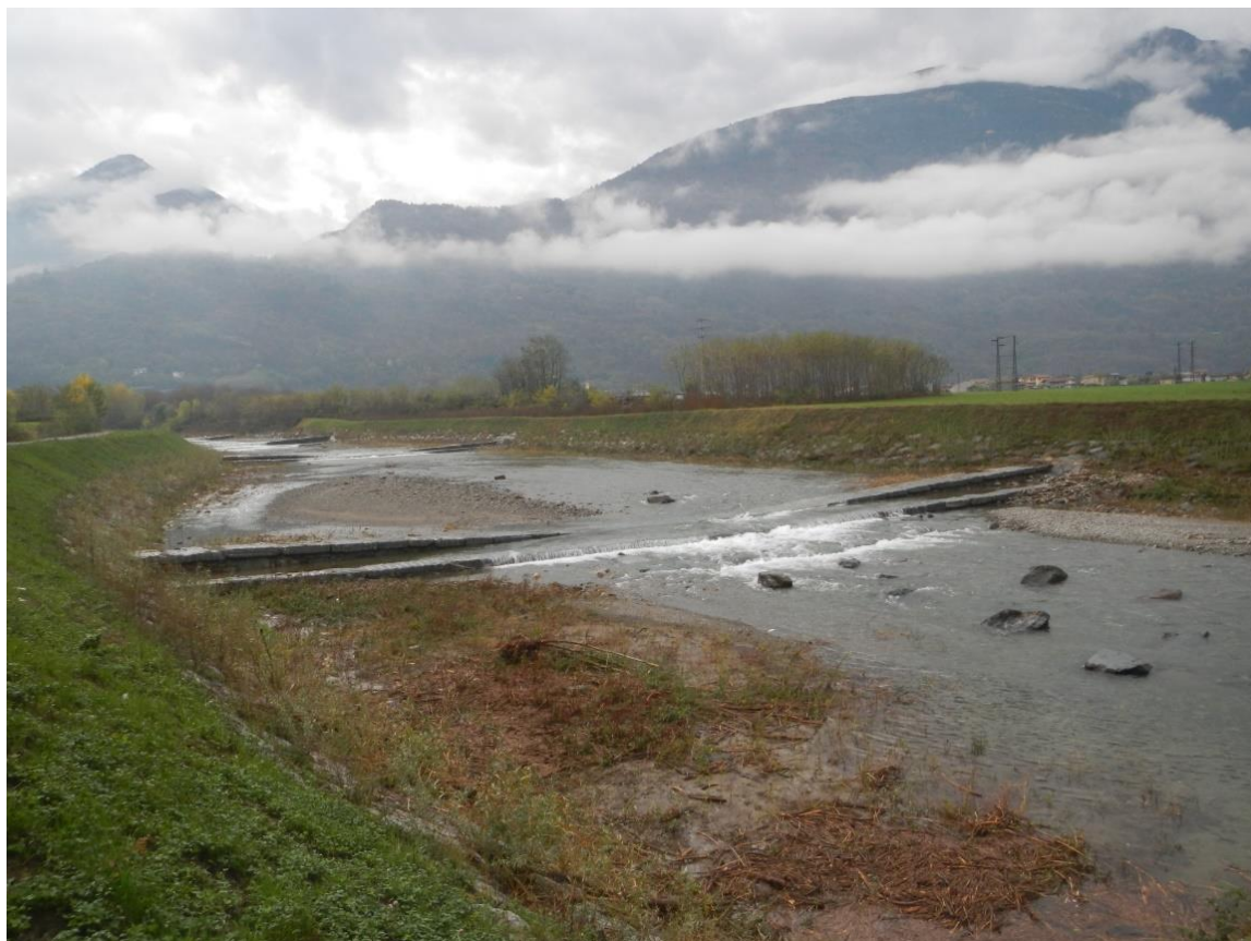
Figura 2.17 Sequenza di soglie proseguendo verso monte.
