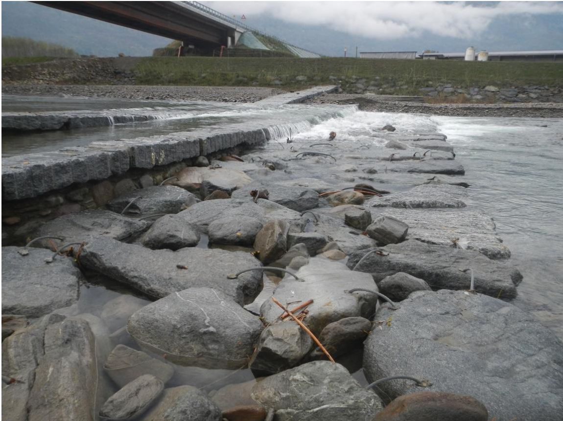
Figura 2.16 Visione laterale della soglia, la quale può costituire ostacolo alla risalita della fauna ittica.
