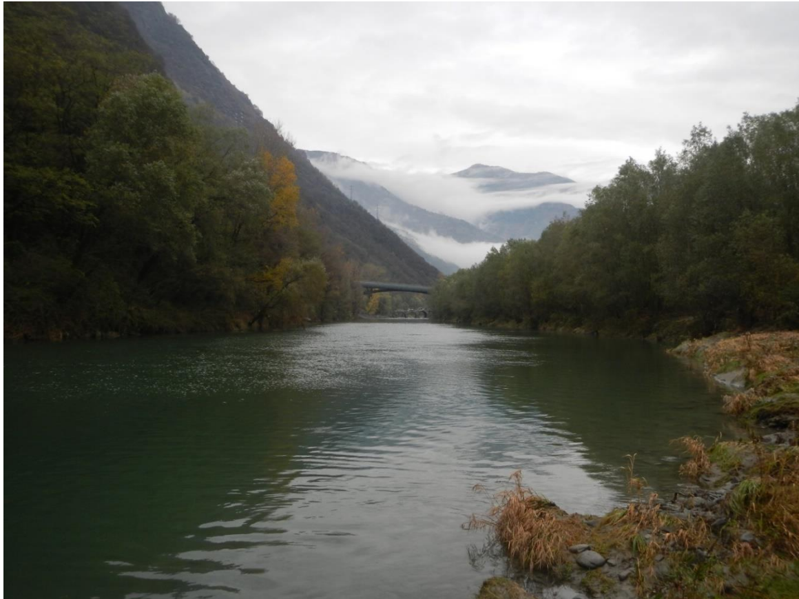
Figura 2.14 Porzione superiore del tratto: a monte è osservabile il viadotto realizzato.
