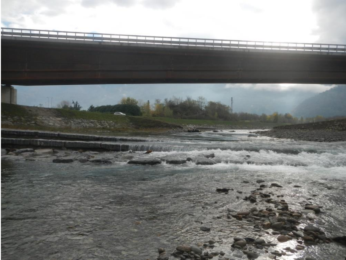
Figura 2.15 Soglia posta immediatamente a monte dell'immissione del Bitto in Adda.
